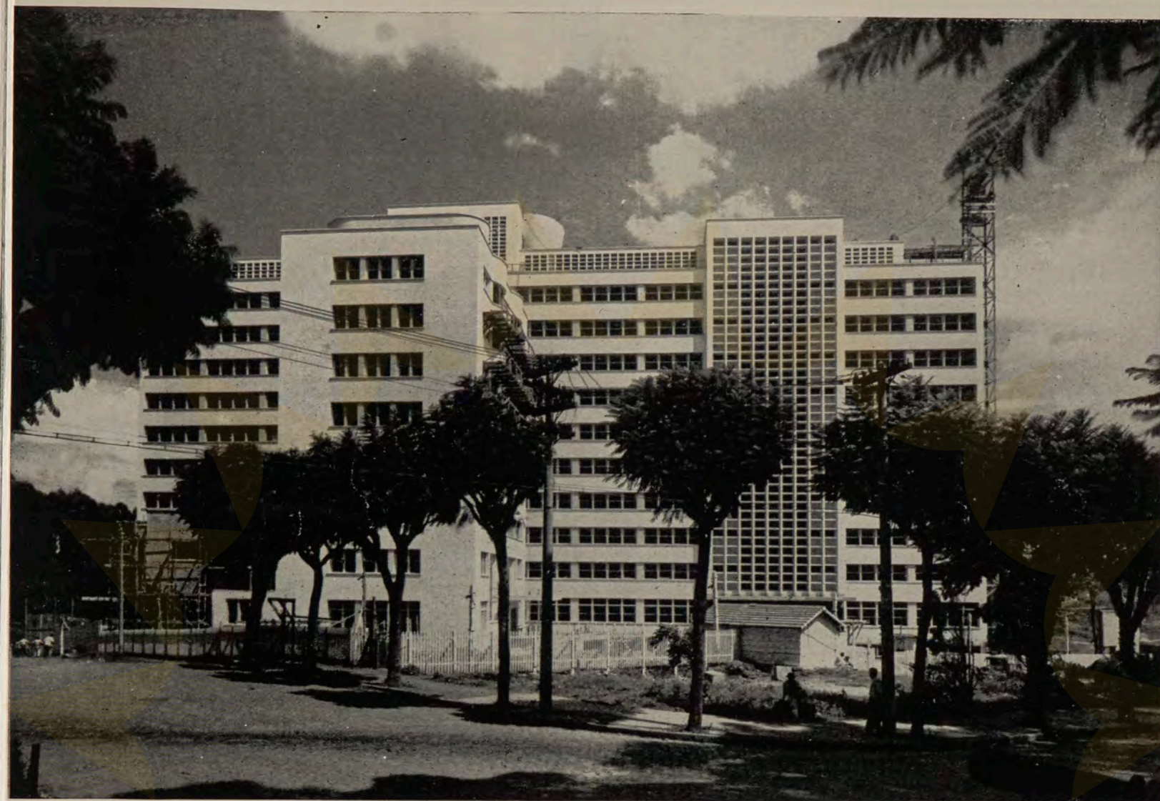
Vista geral do hospital do IAPETC em São Paulo, na última fase da construção
