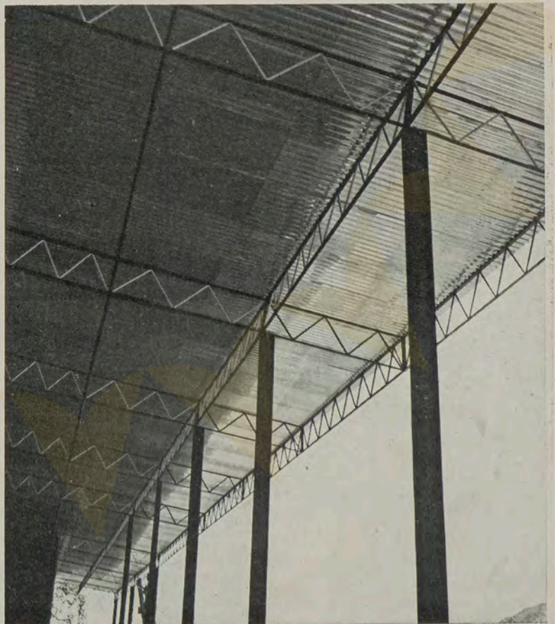
Detalhe da articulação da estrutura pré-fabricada de ferro com o alumínio. Os ferros pintados de branco são vergalhões de 1/2" e os pretos, barras de 1/4" por 1"
