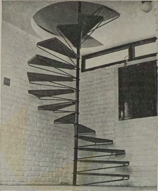
Detalhe da escada de acesso à residência de empregados, executada num vergalhão contínuo de 1/2", soldado a um tubo galvanizado de 2", degraus de madeira
